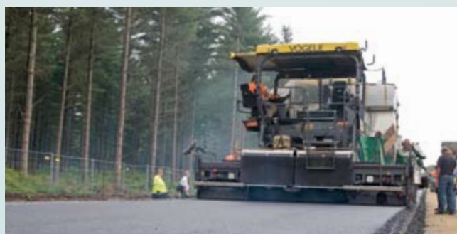
Pose de couches d'enrobé compactes
