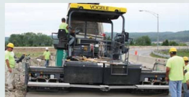
Pose de béton compacté par finisseur (RCC) pour les routes fortement sollicitées
