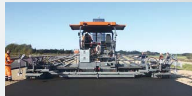
Pose en continu sur de grandes largeurs
