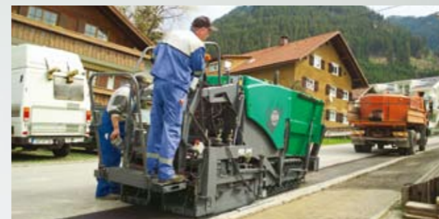
Fermeture de tranchées
