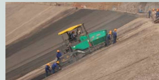
Construction de réservoirs d'eau
