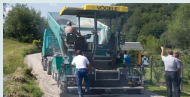
Réalisation de chemins agricoles et de voies d'accès
