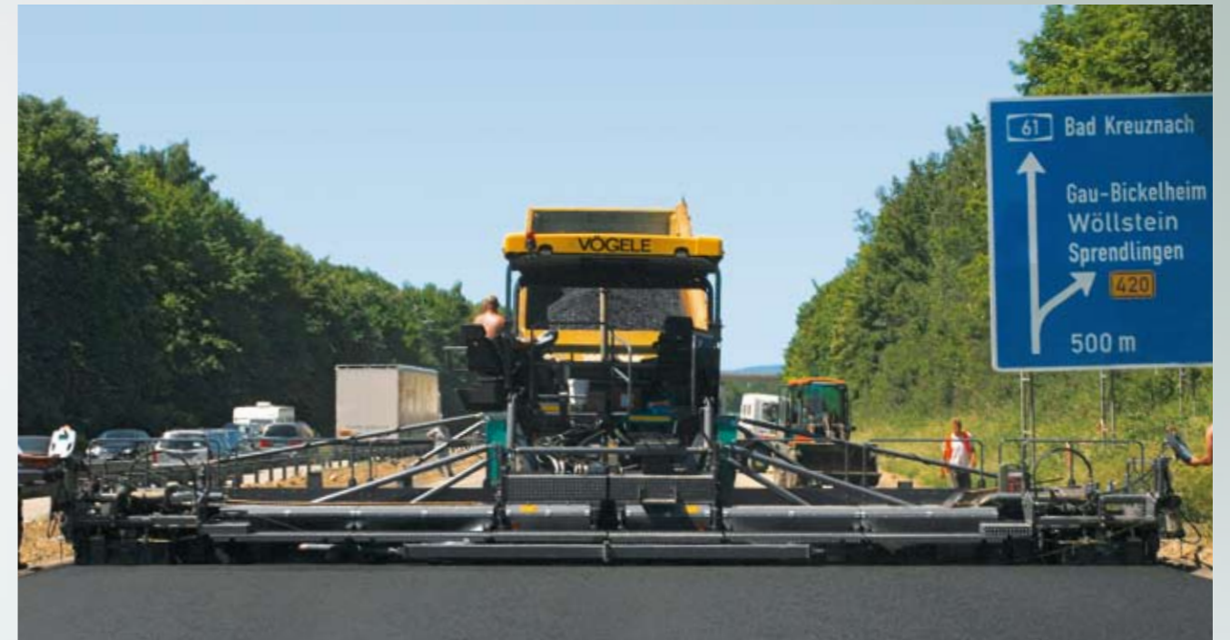
Même en présence de couches de différentes épaisseurs, la technologie à haut pouvoir de compactage de VÖGELE permet d'obtenir des valeurs de compactage homogènes d'un niveau élevé sur toute la largeur de la table.
