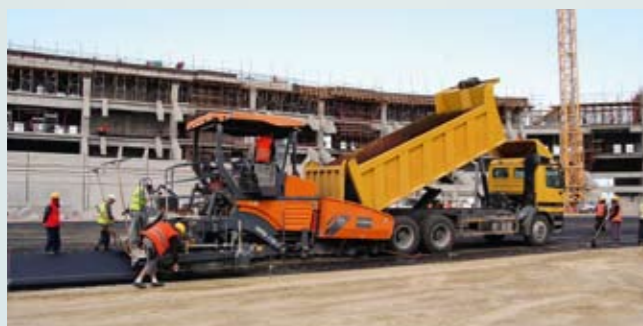
Construction de circuits de courses
