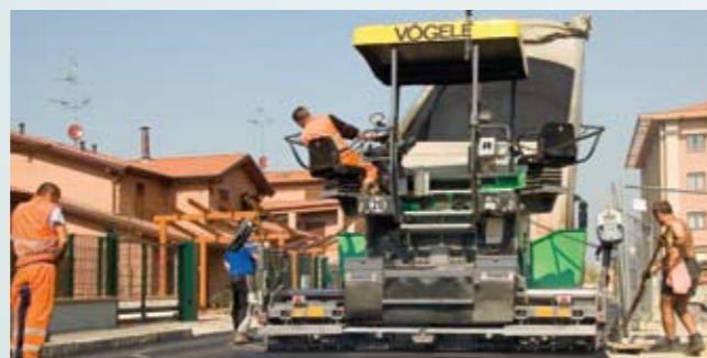
Construction de rues en agglomérations
