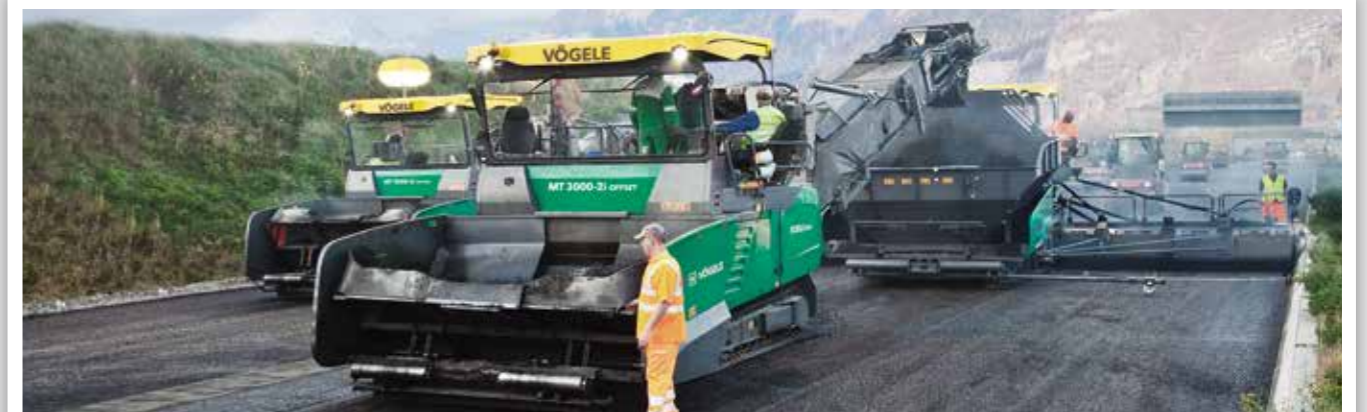
ALIMENTATION DE FINISSEURS LORS D'UNE POSE « CHAUD À CHAUD »
