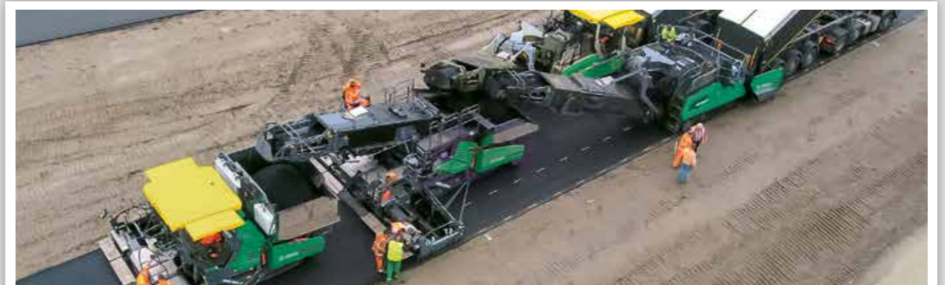
ALIMENTATION AVEC L'ATELIER DE POSE INLINE PAVE
