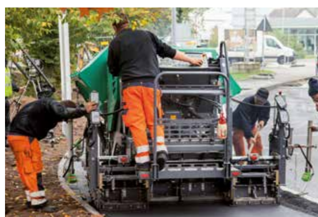
CONSTRUCTION DE CHEMINS RURAUX
