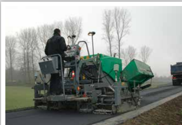
POSE D'ENROBÉ SUR DES DIGUES
