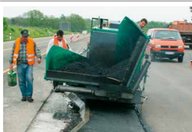
POSE D'ENROBÉ SUR LE TERRE-PLEIN CENTRAL D'AUTOROUTES
