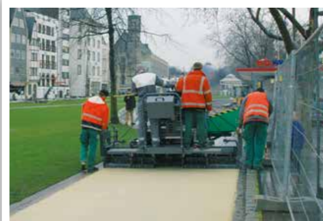
CONSTRUCTION DE CHEMINS EN ESPACES VERTS
