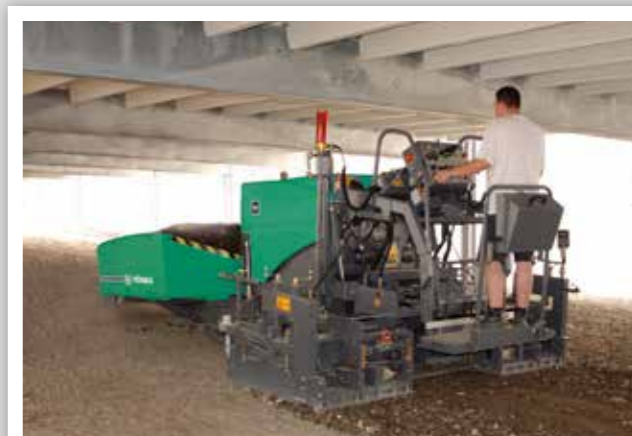
RÉALISATION DE L'ASSISE POUR UNE POSE DE PAVÉS
