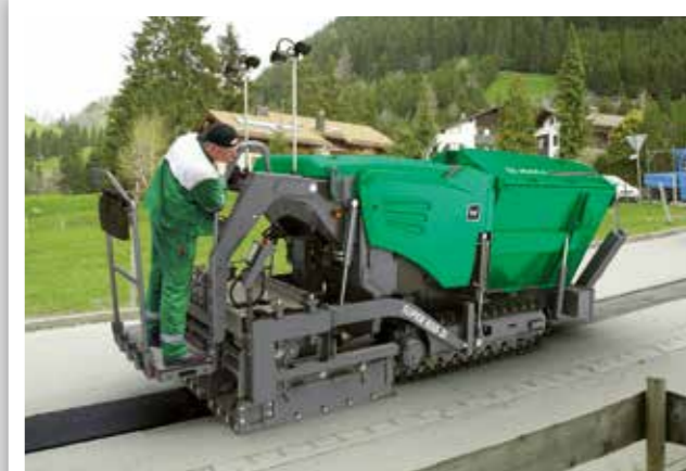
FERMETURE DE TRANCHÉES DE CANALISATION
