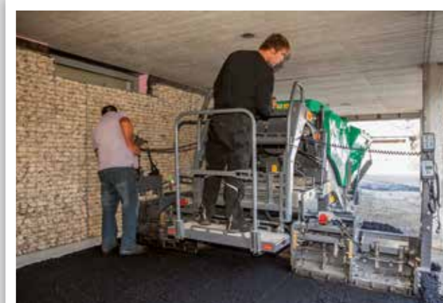
POSE D'ENROBÉ DANS DES HALLES INDUSTRIELLES
