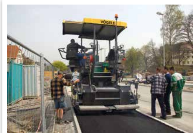
POSE D'ENROBÉ SUR TROTTOIRS / PISTES CYCLABLES COMBINÉS
