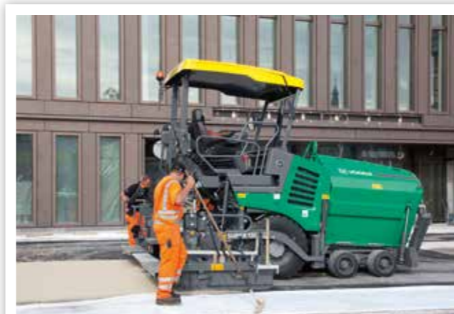
POSE D'ENROBÉ EN ZONES INDUSTRIELLES ET COMMERCIALES
