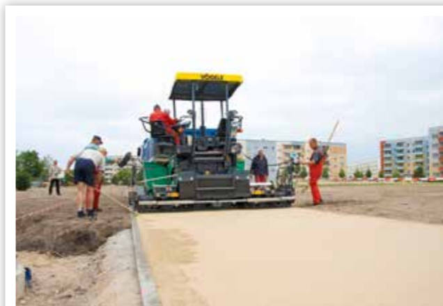
RÉFECTION DE VOIES D'ACCÈS
