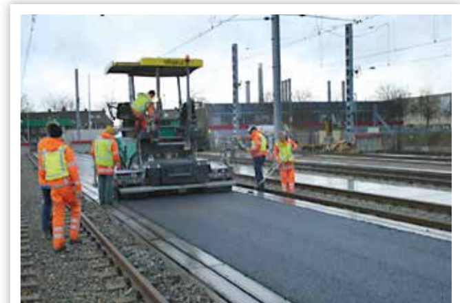
POSE D'ENROBÉ SUR LES QUAIS DE GARE
