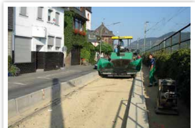
RÉFECTION DE VOIES URBAINES
